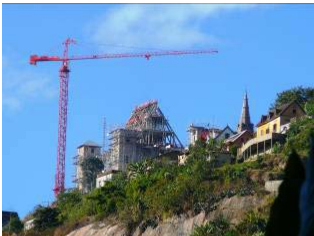
Wiederaufbau des Rova
